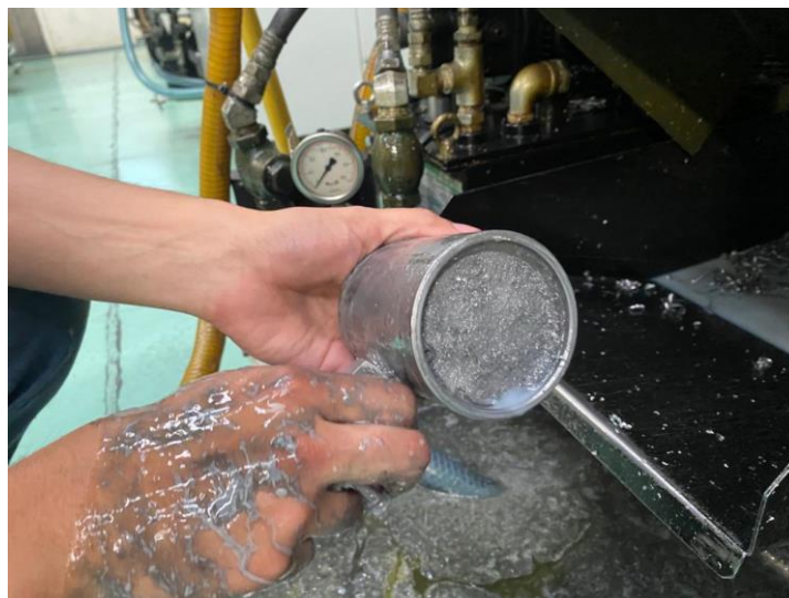
Imagen 24. Filtro de refrigerante con exceso de rebaba
