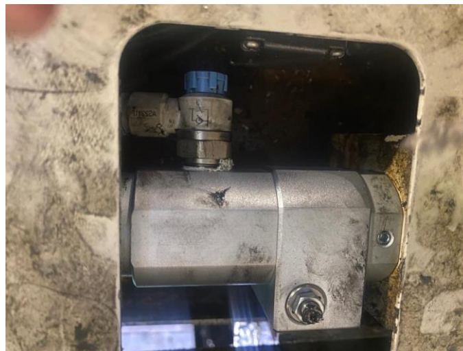
Imagen 26. Aria del cilindro de aire sucia
