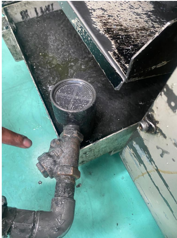
Imagen 55. Válvula ya colocada
